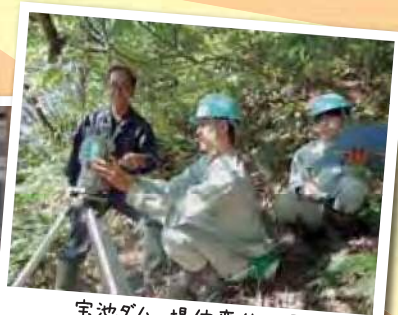
宝池ダム 堤体変位測量
