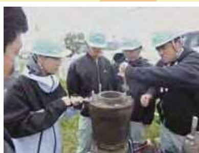
大願幹線 空気弁点検作業
