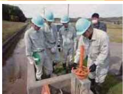
幌向川左岸幹線 断水作業
