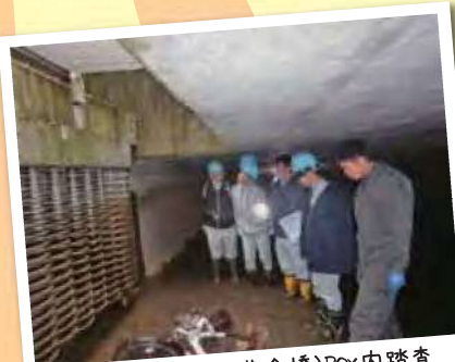
北海幹線(6条～黄金橋)Box内踏査
