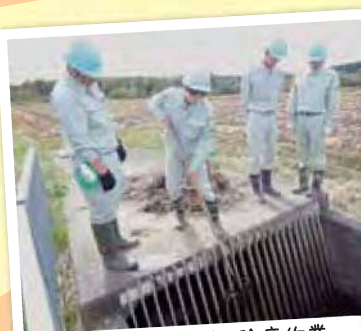
幌向川左岸幹線 除塵作業
