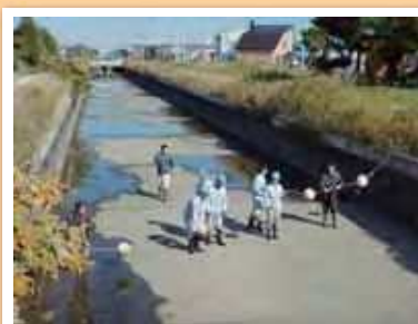
北海幹線 救命ロープ取り外し作業
