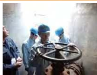
幌向川左岸幹線 断水作業
