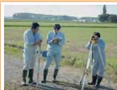
川向2幹線岩3支線 横断測量
