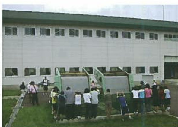
南幌町 南幌向揚水機を見学
