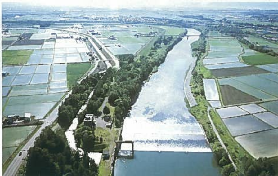
赤平市から南幌町まで延長約80kmに及ぶ北海幹線用水路
