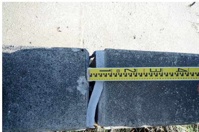
北海幹線（南幌）浮上による目地離脱状況
