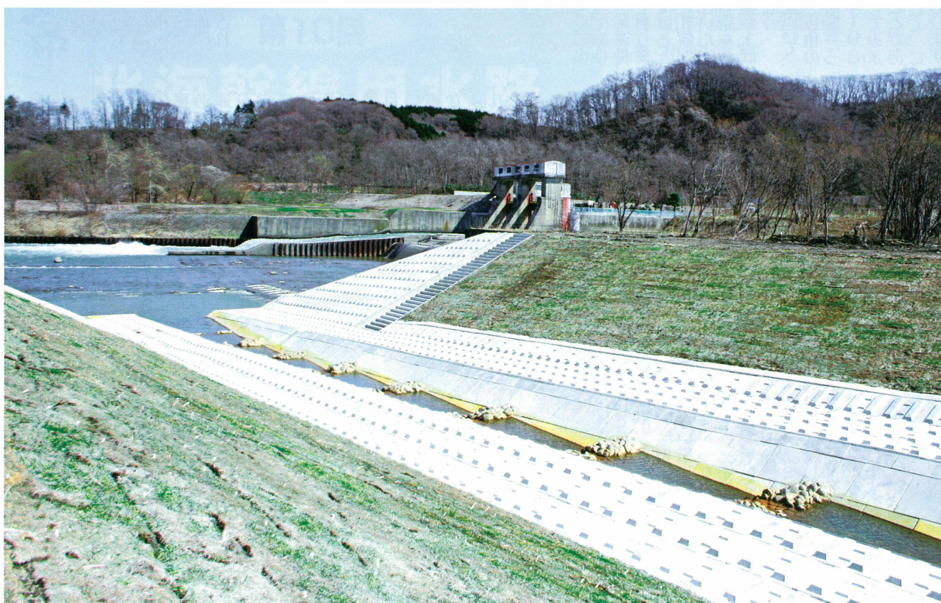
『栗沢頭首工 魚道』
